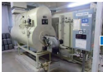
Refroidisseur à absorption au mazout
